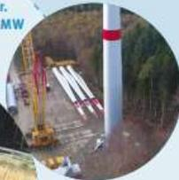
Stahlrohrturm aus 5 Segmenten
