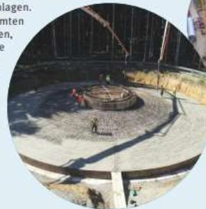
Betonfundament: Durchmesser 29 m Höhe 3,5 m
